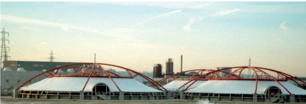
BASSINS DE DÉCANTATION
